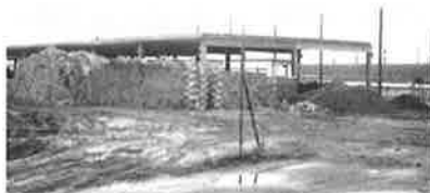
Výstavba zděných kabin na ZS Kralupy.
